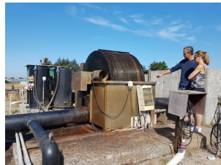
Figur 14. Trumfilter för filtrering av inloppsvatten till dammarna vid Venø, Danmark.
