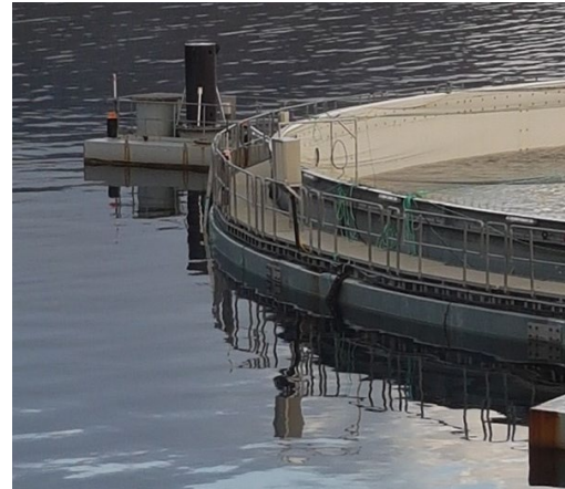
Figur 19. Flytelementen på Neptun 3 syns som en grå kant som går ner i vattnet under spången runt tanken.
