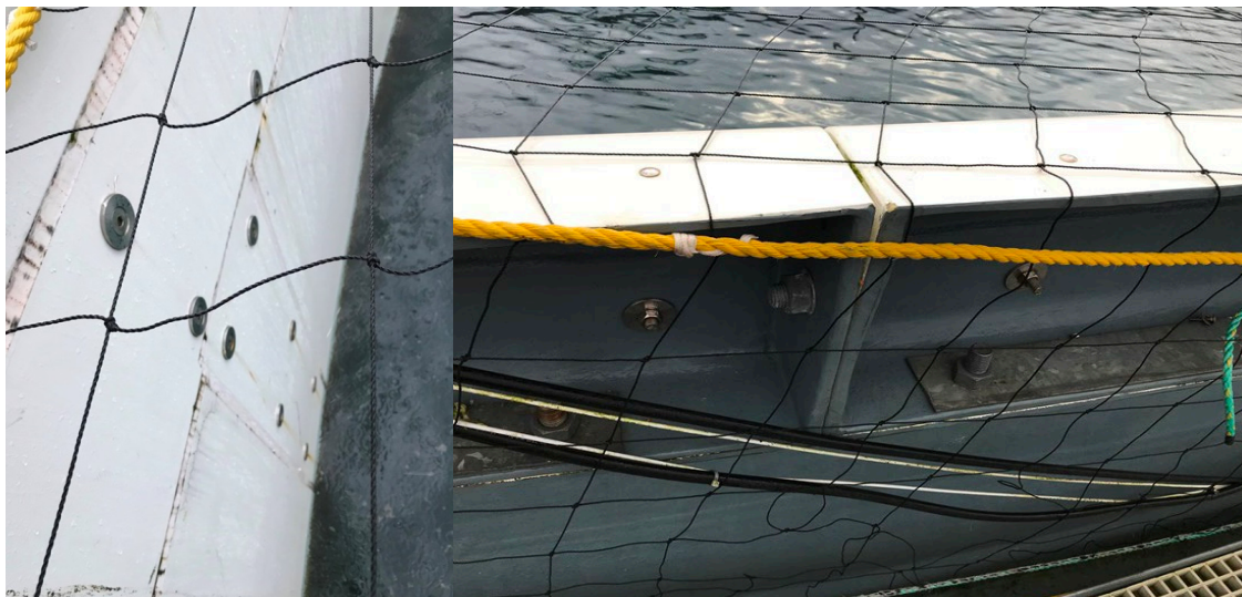
Figur 18. a) GRP förstärkning av segmentskarvar på insidan av Neptun 3. b) Höjning av sidan av Neptun 3 samt skarv med fläns mellan två segment.
