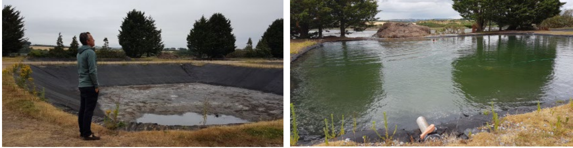
Figur 4. Dammarnas konstruktion, 2,5 m djupa, sluttande sidor och Butylklädda, samt inlopp.
