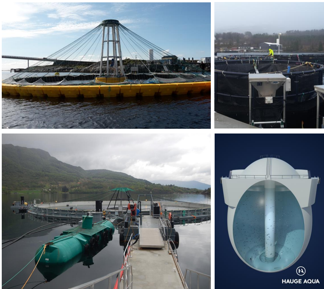
Figur 4. Exempel på nya semi-slutna (övre bilder) samt slutna odlingsystem som kan användas i hav och i inlandsvatten. Foton övre: Kristina Sundell. Nere till vänster: Anette Ungfors. Illustration till höger: Hauge Aqua www.haugeaqua.com
